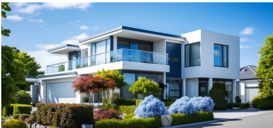
Příklad rodinného domu, který je vybaven decentrálním systémem větrání.
