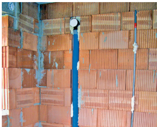
Detail přechodu hadice ED Flex® 75/63 do jámky pro talířový ventil EDF-SJ-100/75
