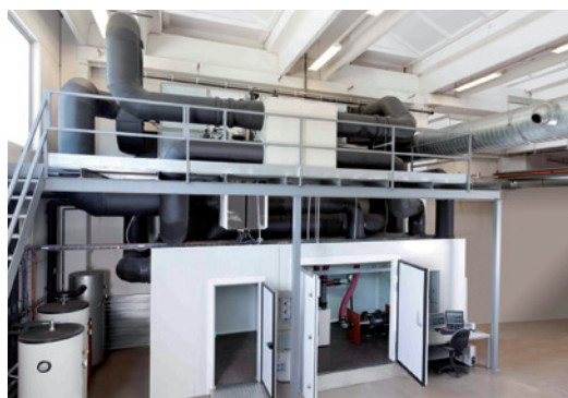
Klimatická komora pro testování rekuperačních jednotek
