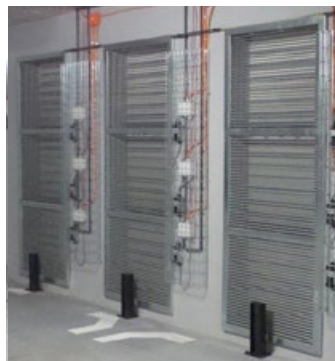
obrázek č. 10 – příklady instalace žaluziových klapek ve stěně
