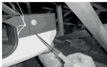
plochým šroubovákem odstraňte kryt svorkovnice
