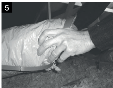
přetáhněte kryt izolace až k zářežce "A"
