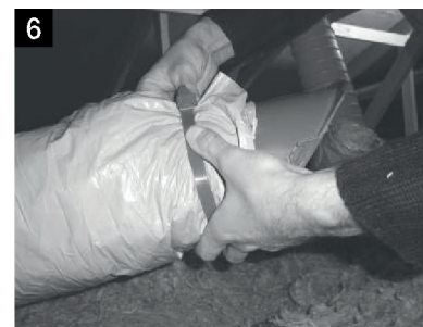
zajistěte potrubí pomocí zdrhovací pásky EASYFIX
