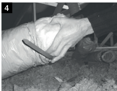
přetáhněte izolaci až k zářežce "A"
