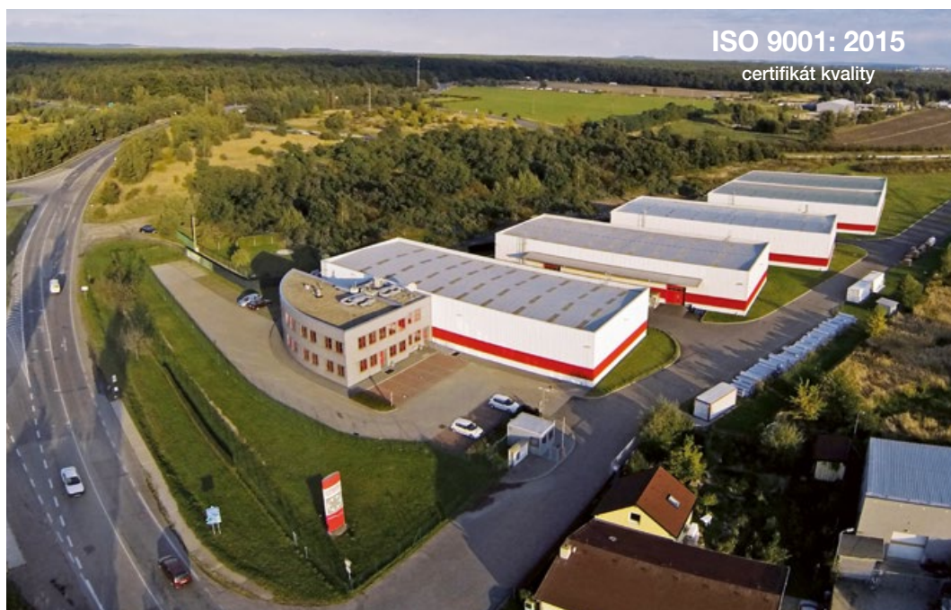
Logistický areál ELEKTRODESIGN ventilátory s.r.o. ve Staré Boleslavi v prostoru mezi dálnicí E65/D10 a vnitřní komunikací do Staré Boleslavi.
