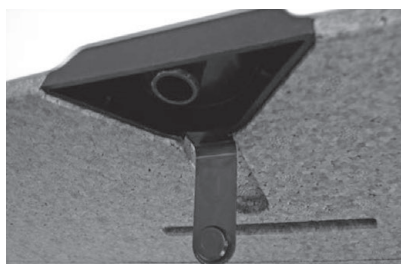
b) Instalace flexibilní hadice Napojte flexibilní hadici na odvod kondenzátu
