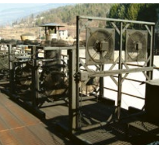
Prüfungen im Außenbereich
